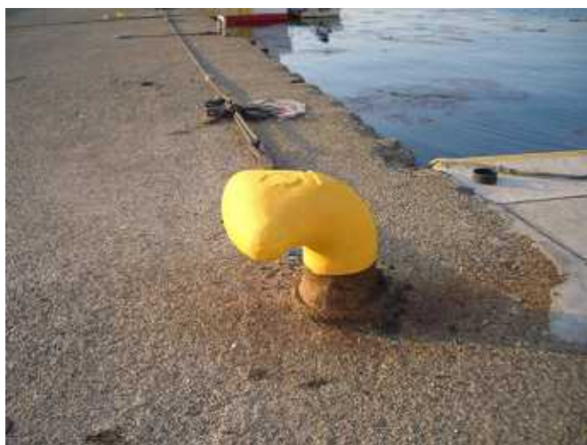
R形係船柱ブライトコート塗装後
