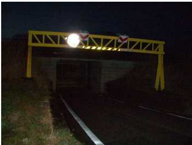
塗装前（夜間） ストロボを使用したもの
